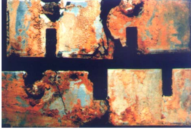
Şekil 10. Sıcak kullanım suyundaki boylerin paslanmaz çelik (1.4541) plakaları. Yırtıkların yanında kaynak noktalarındaki korozyon tehlikesi rahatlıkla görülmektedir.
